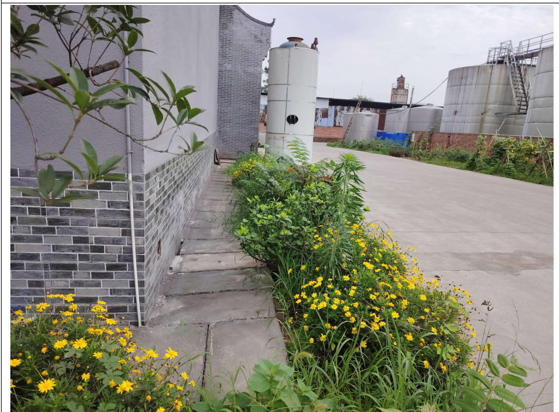
图 4 项目绿化及排水沟现状
