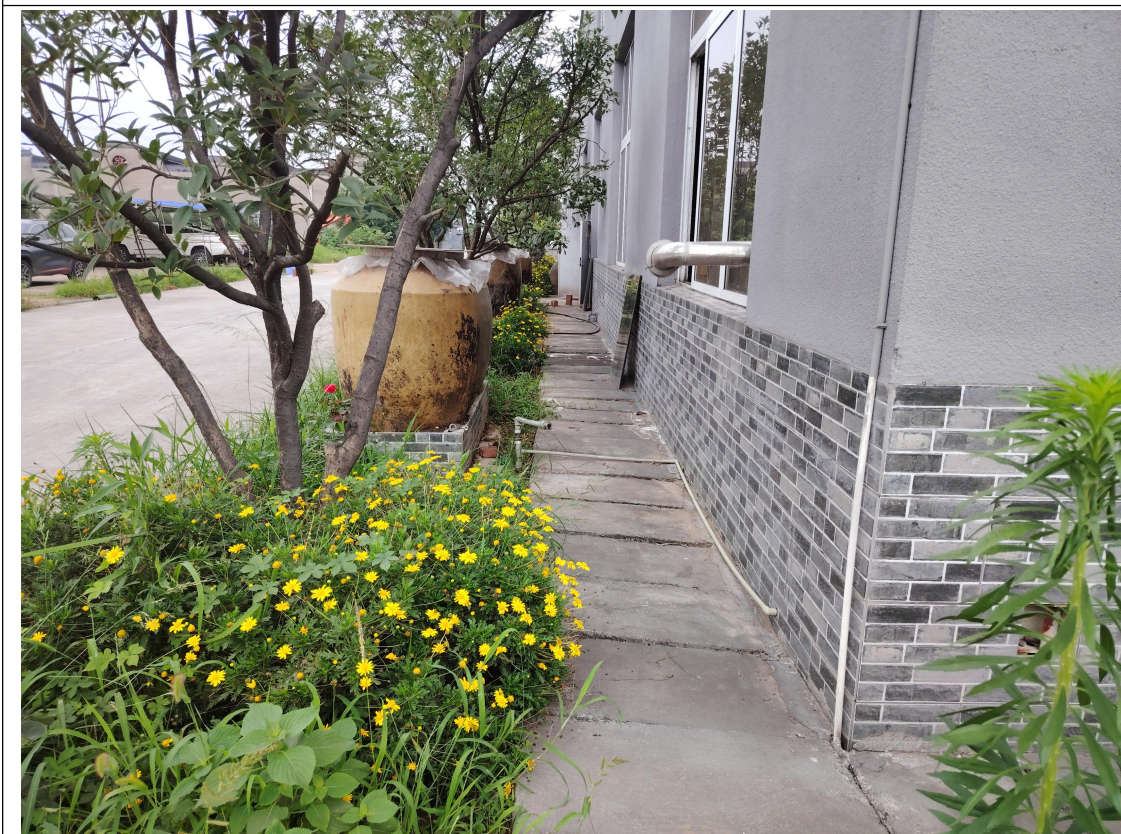
图 6 项目绿化及排水沟现状
